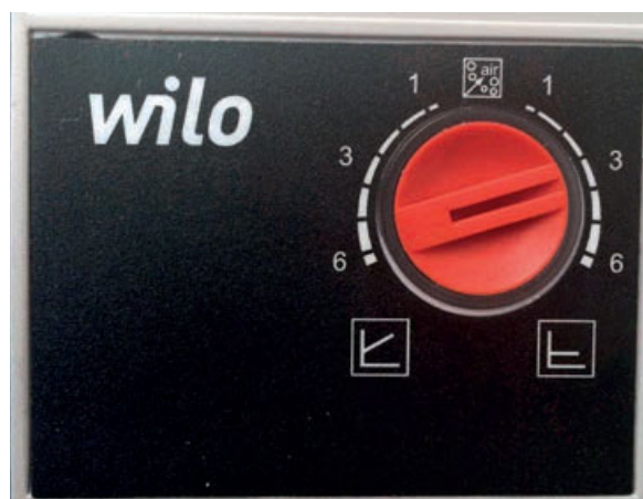
Bild: Justering av cirkulationspump
