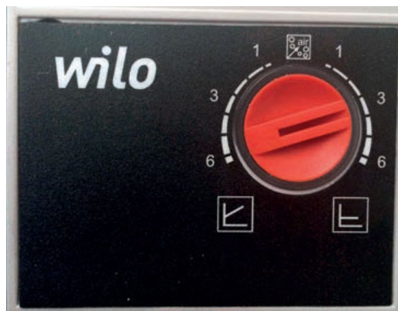
Bild: Justering av cirkulationspump
