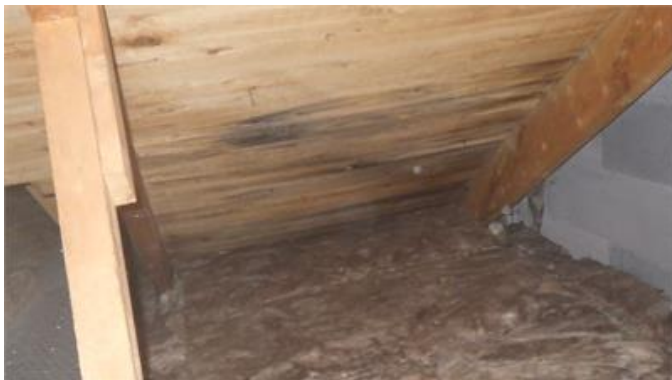
Fuktfläck på insida yttertaket på vinden
