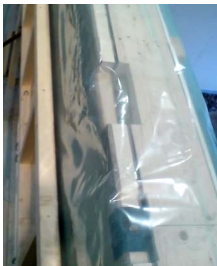
Figur 3.4: Ångspärrens placering i väggen för MFB
