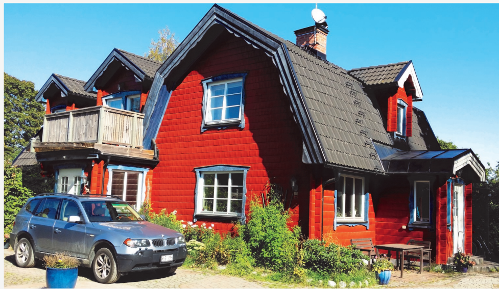
Om- och tillbyggnad. Det befintliga huset bevaras inne i den nya stommen.
